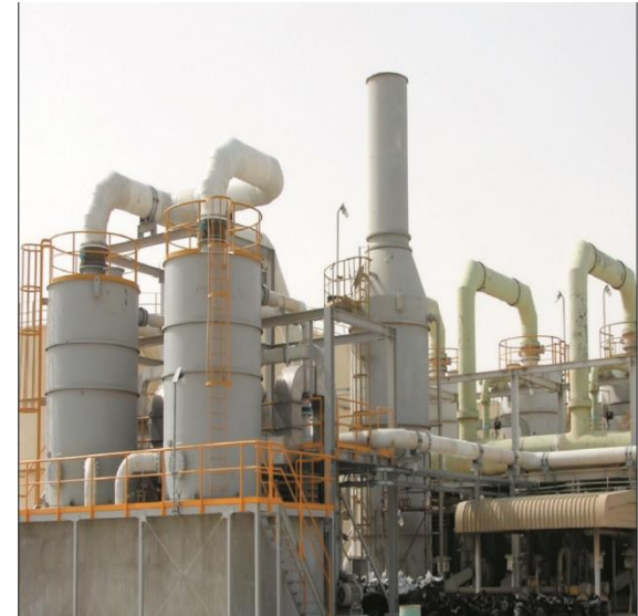
أبراج التخلص من غاز كبريتيد الهيدروجين H_2S
