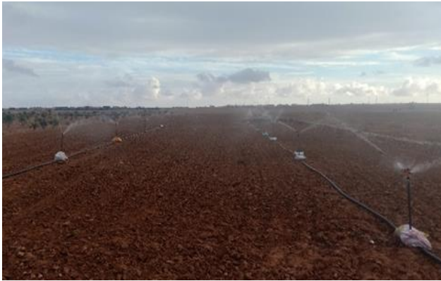
شبكة الري بالرش بعد التركيب
