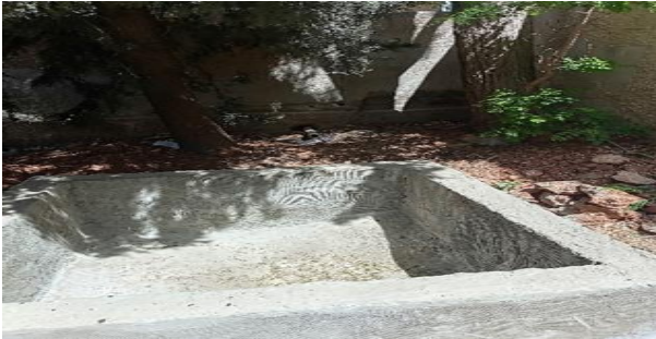
صورة توضح خزان تجميع المياه الرمادية
