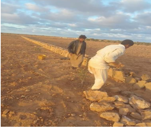
تنفيذ السدود الحجرية تمهيداً لزراعة القمح
