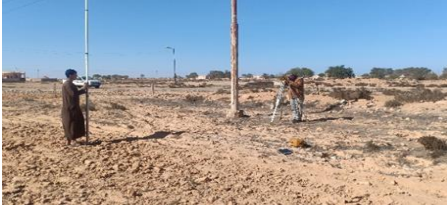
أعمال الرفع المساحي
