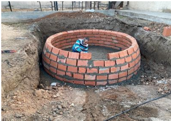
صورة توضح بناء جسم الهاضم الحيوي
