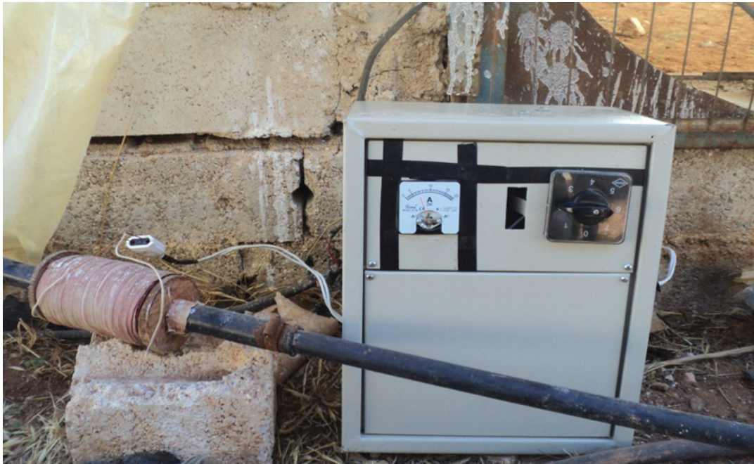
الشكل 2. مصدر التغذية والملف في جهاز مغنطة المياه.
